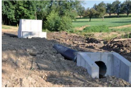
Damm durchführung (Ein- und Auslaufbauwerk)
