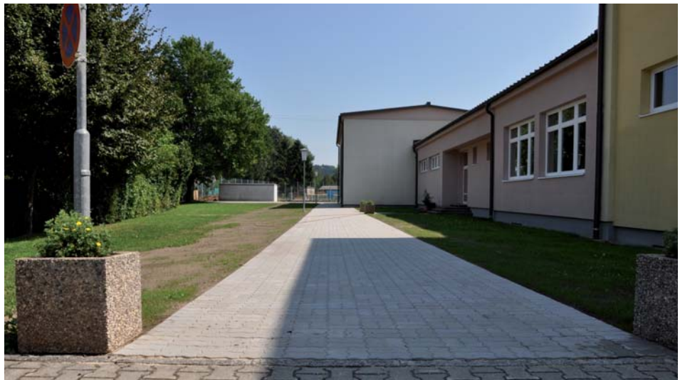
Bild rechts: Verbreiteter, neu gepflasterter Verbindungsweg zum Turnsaal und zum Tennisplatz
