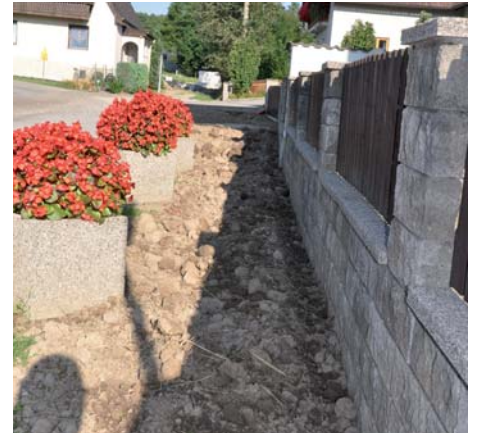
Schächte wurden verrohrt und verschlossen
