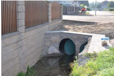
Einlauf vor der Straßendurchführung
