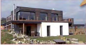
Das Haus wurde als Leichtbau hergestellt und ist ein Niedrigenergiehaus mit Strohdämmung. Es besticht durch seine ökologische Bauweise und die Einbindung in das Gelände.
